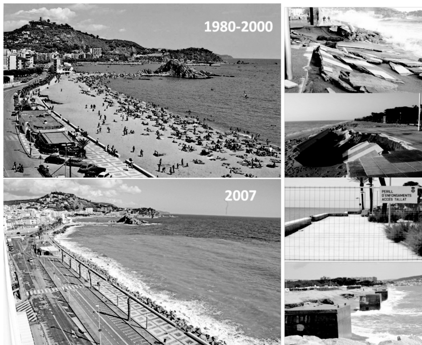
Figura 4. Izquierda: Desaparición de los sedimentos en la playa de S'Abanell, desde una situación más o menos estable (período 1980-2000) a un proceso de erosión rápida observado en la última década que concluyó en 2007. Derecha: imágenes de destrozos provocados en la playa debido a la reducción de la función de protección de la playa.
